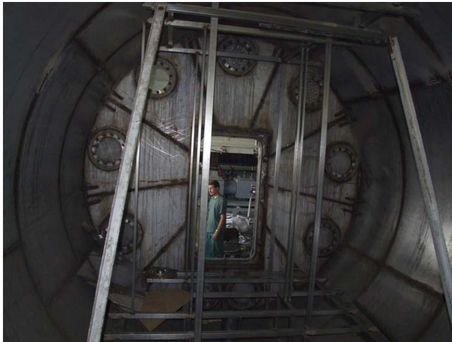
„noch im Rohbau ist der Fitnessraum des Haushaltmodules mit seinen insgesamt 250 m 3 Raum“
