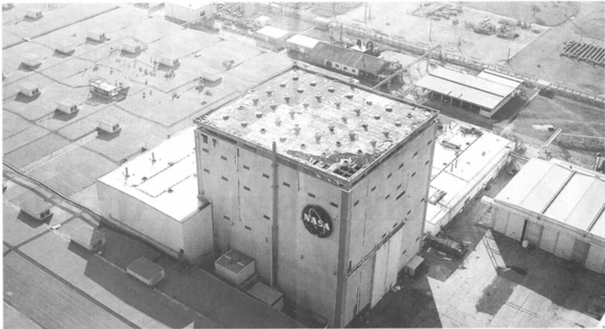
Beschädigter Komplex des Nasa-Zentrums in New Orleans, in das sich nach dem Hurrikan 4000 Menschen flüchteten.
